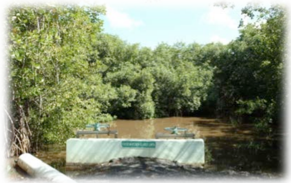
Fotografía 8. Una de las compuertas ubicada en el dique oeste del RVSILAM
