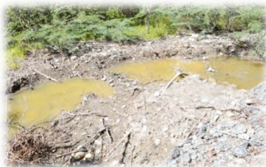
Fotografía 35. Aguas empozadas en la vereda larga del dique oeste en el RVSILAM
